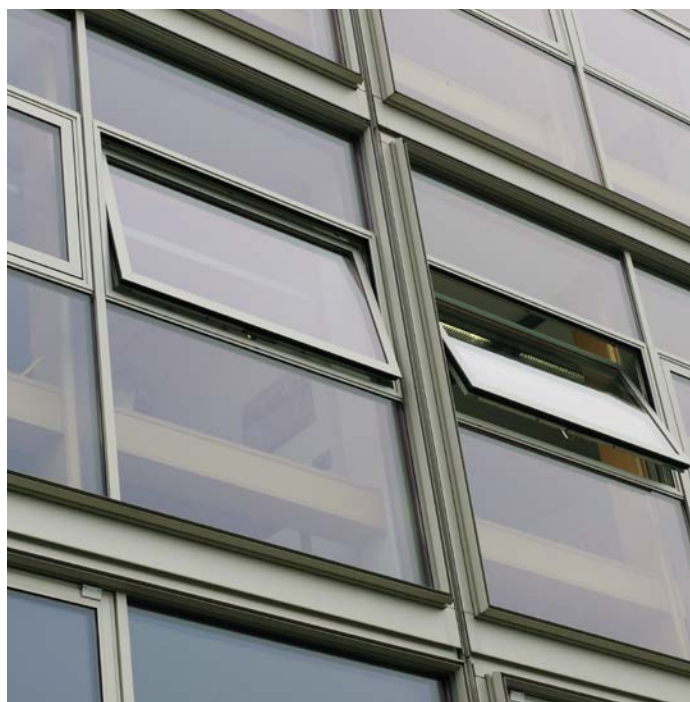
Leibnitz Rechenzentrum, Garching (D)
